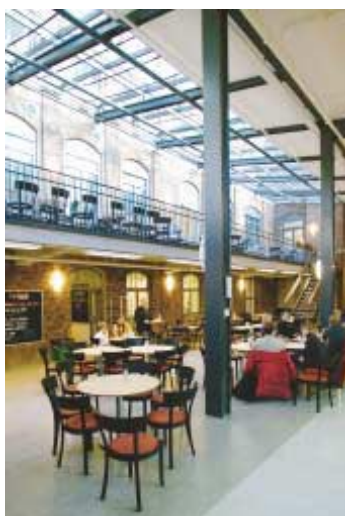
Två yttreväggar har blivit innerväggar i den nya kafeterian.
